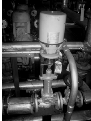
Figura 10. Válvula reguladora de flujo
