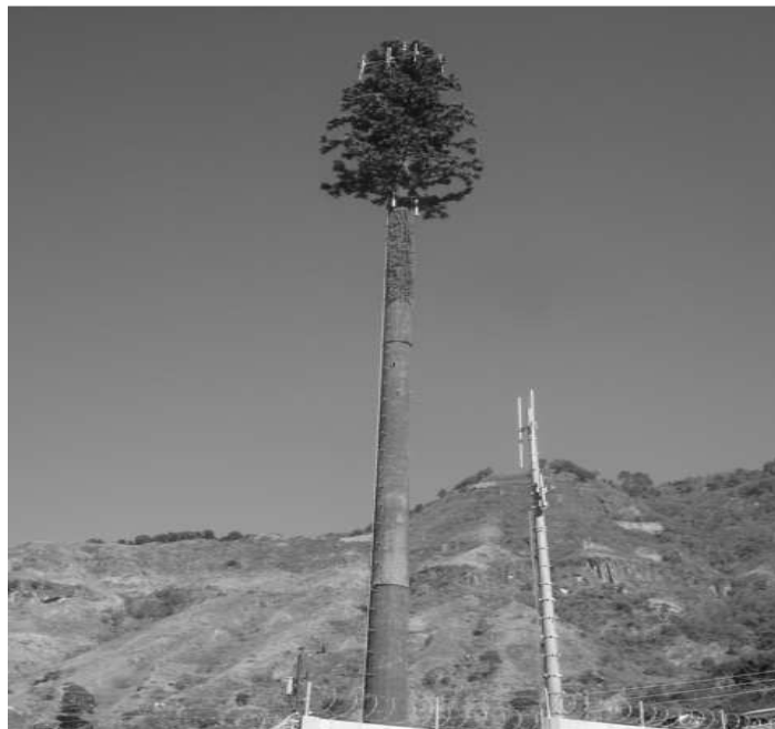
Imagen 5: Estructura tipo monopolo. 9
