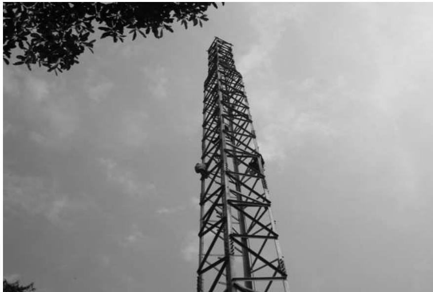
Imagen 3: Estructura cuadrada autoportada tipo celosía. 5
