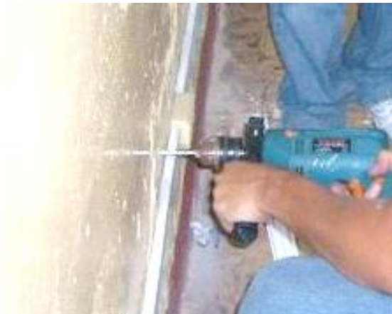
Figura 6. Instalación de canaleta
