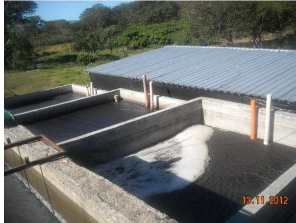
Figura 6. Pilas de sedimentación
