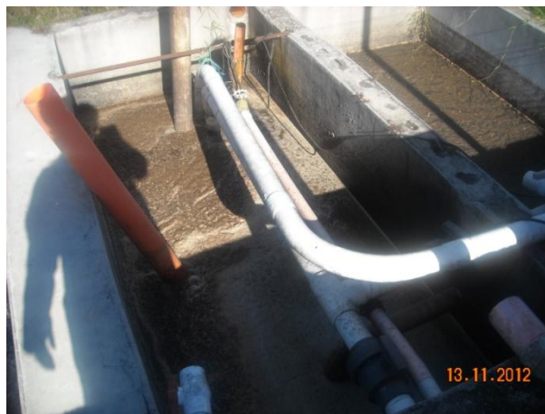
Figura 3. Tanque homogenizador
