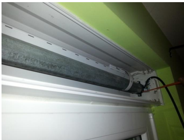
Figura 42. Instalación de persiana motorizada y ajuste de finales de carrera del motor
