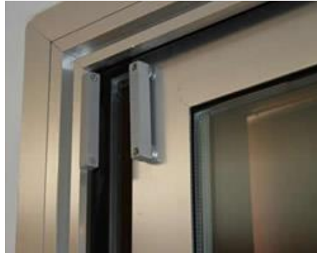
Figura 44. Instalación de sensor magnético en puerta
