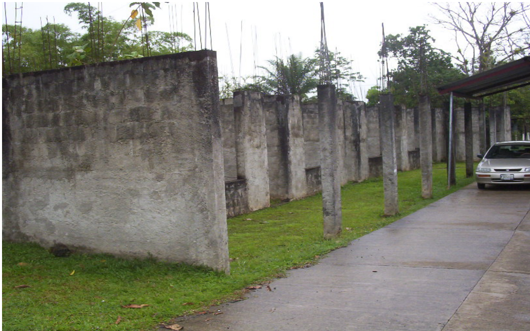
Figura 19. Nuevas oficinas administrativas
