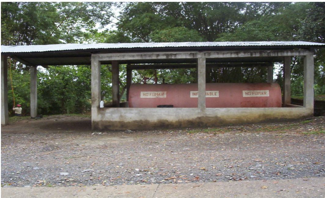
Figura 18. Tanques de combustible
