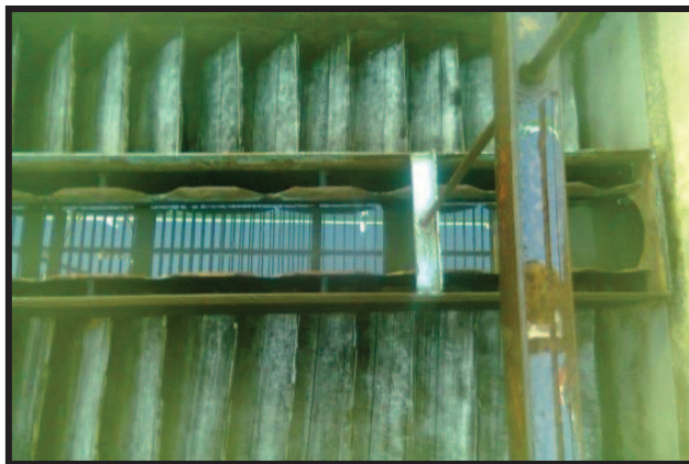
Figura 41. Sedimentador laminar
