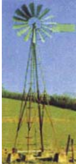
Figura No. 6. Molino típico para bombeo de agua
