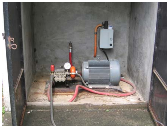
Figura 6. Bomba hidráulica para llevar a cabo la prueba de ruptura
