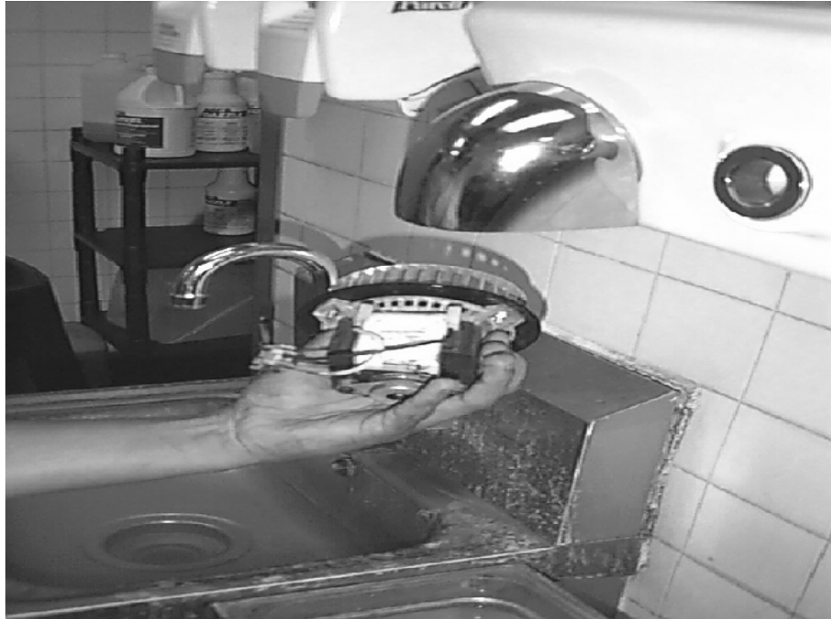
FIGURA 21. Secado del ventilador
