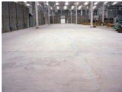
Figura 14. Piso edificio de destilación
