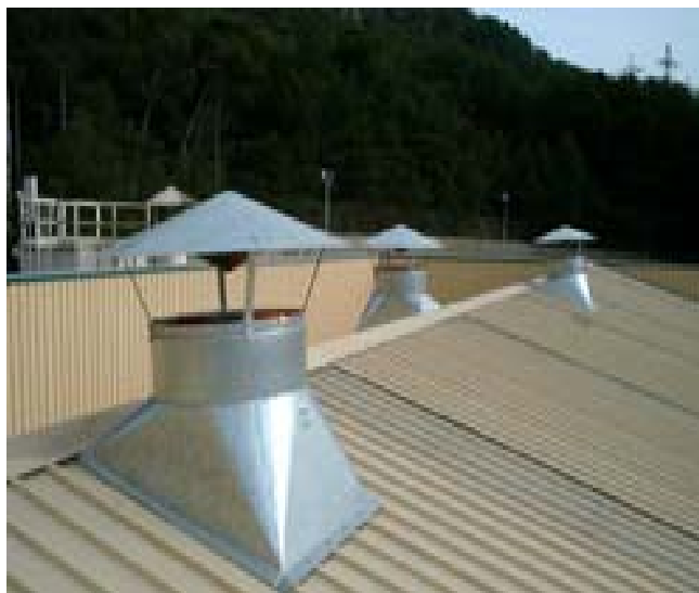
Figura 13. Techo edificio de destilación
