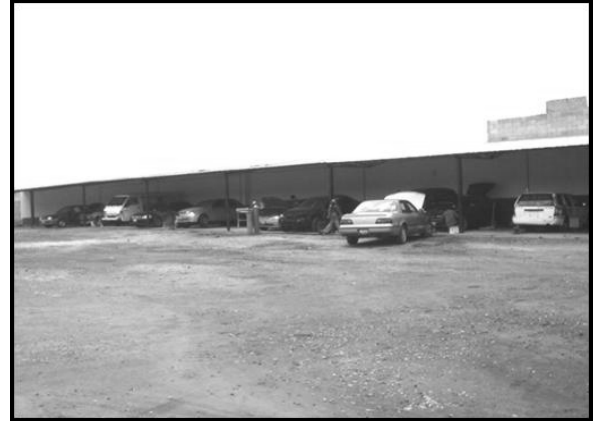
Figura 8. Área de enderezado y mecánica (Taller San Cristóbal)
