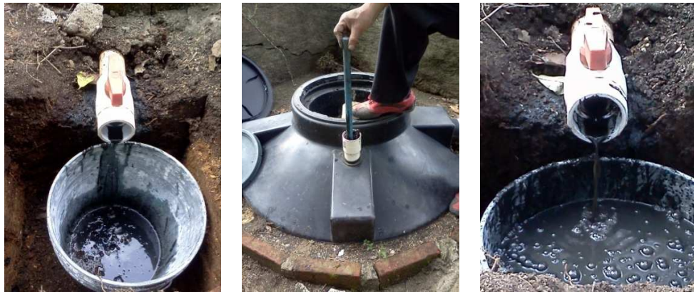
Figura 17. Extracción de lodos
