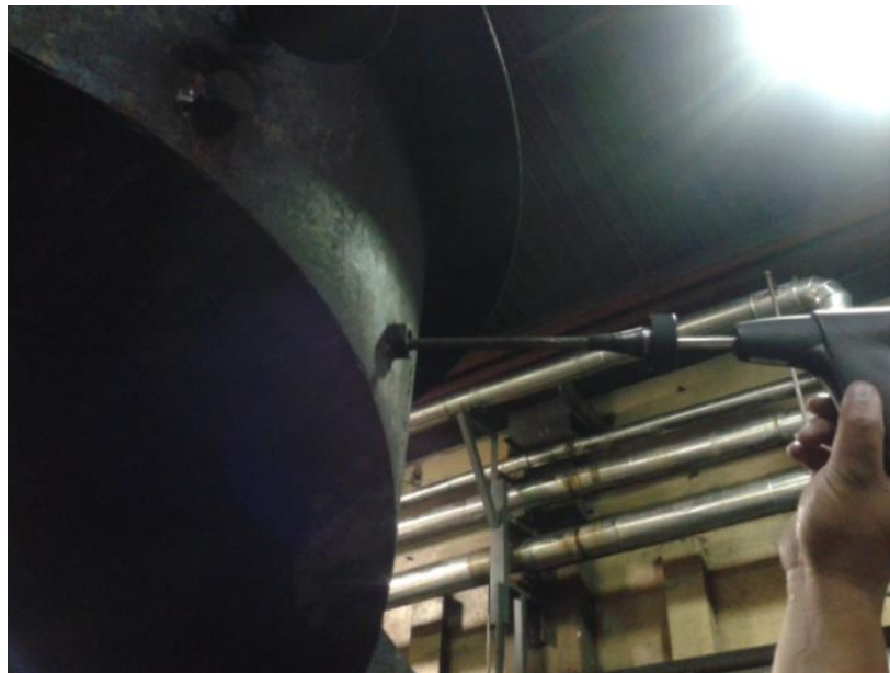
Figura No. 6 Toma de muestra de gases de combustión
