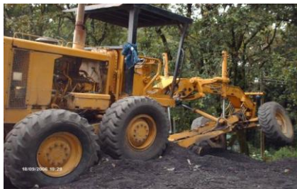
Figura 56. Nivelación de superficie o rasante en carretera, realizada por moto niveladora
