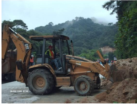
Figura 55. Actividad de demolición y limpieza realizada por retroexcavadora
