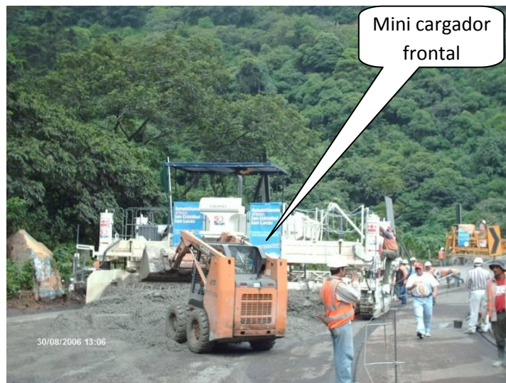
Figura 40. Mini cargador frontal empleado para distribución frontal del concreto
