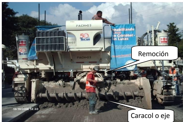
Figura 23. Remoción de residuos de concreto en eje o caracol de esparcido
