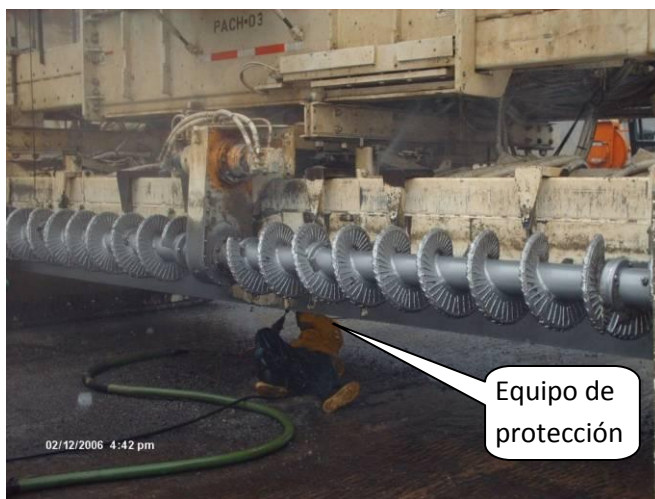
Figura 25. Limpieza superficial profunda con equipo de protección
