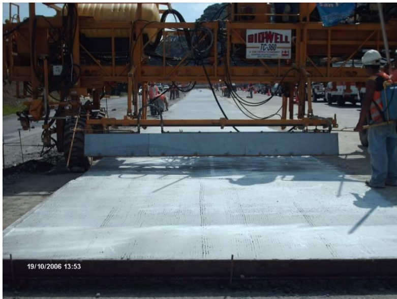
Figura 36. Principales sectores evaluados in situ para garantizar el flujo de materiales complementarios a la superficie del concreto colocado
