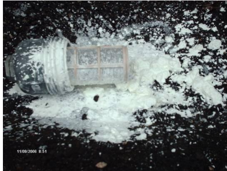
Figura 33. Filtro de texturizadora al momento de ser revisado en un mantenimiento in situ
