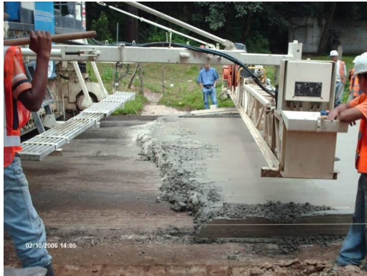
Figura 22. Remoción de residuos en tornamesa de alisado de concreto superior a 2 pulgadas
