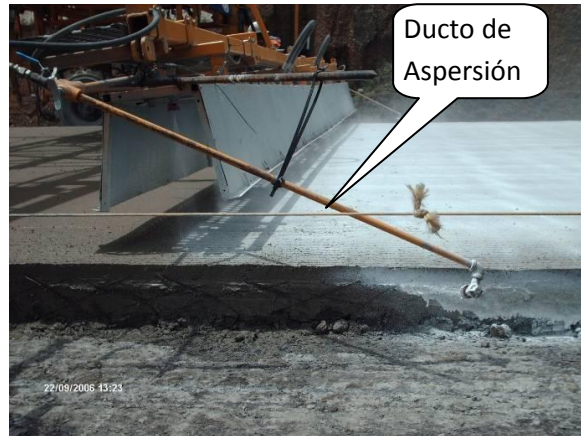
Figura 39. Aspersión de materiales para la textura superficial del concreto
