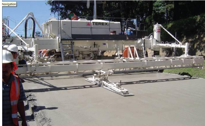
Figura 5. Pavimentadora TEREX SF3502B
