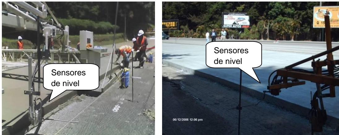
Figura. 9. Sensores de nivelación, componente sugerido por operadores de los equipos en campo para su calibración en planta
