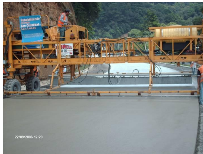
Figura 31. Máquina de texturizado Terex Bid-Well TC-360
