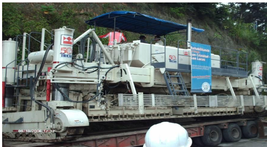
Figura 8. Traslado de equipo primario (pavimentadora o esparcidora de concreto) hacia planta de distribución para realización de mantenimiento mayor
