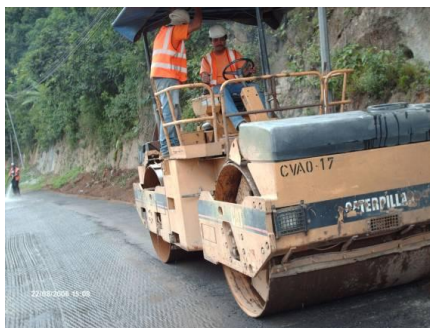
Figura 57. Compactación de superficie nivelada, realizada por vibro compactador neumático con control de operador
