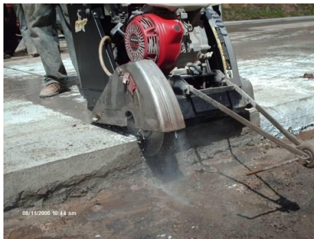
Figura 47. Utilización de cortadora de concreto en pavimentos
