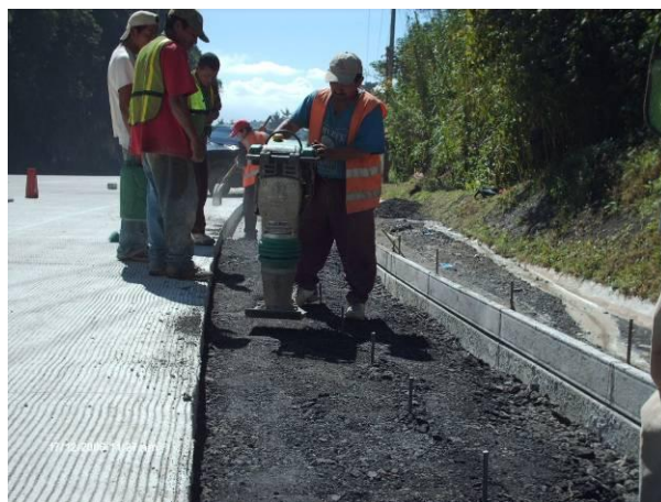
Figura 54. Actividades realizadas utilizando vibro compactador manual
