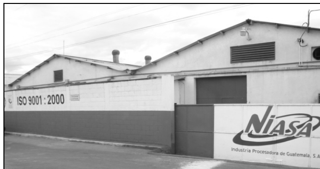
Figura 1. Vista frontal de Industria Procesadora de Guatemala S.A.
