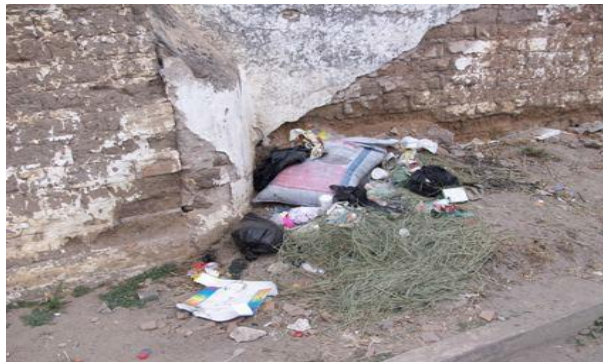
Figura 32. Almacenamiento fuera de las viviendas
