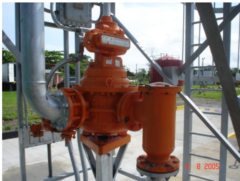
Figura 2. Medidor Smith doble cubierta y desplazamiento positivo
