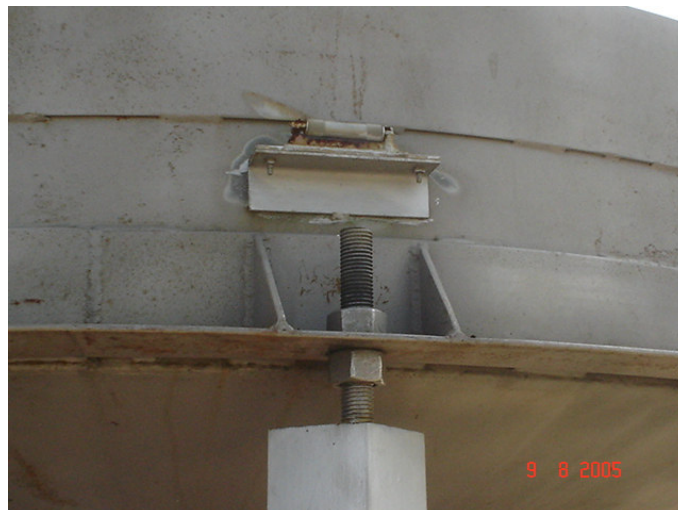
Figura 16. Nivel del probador volumétrico.
