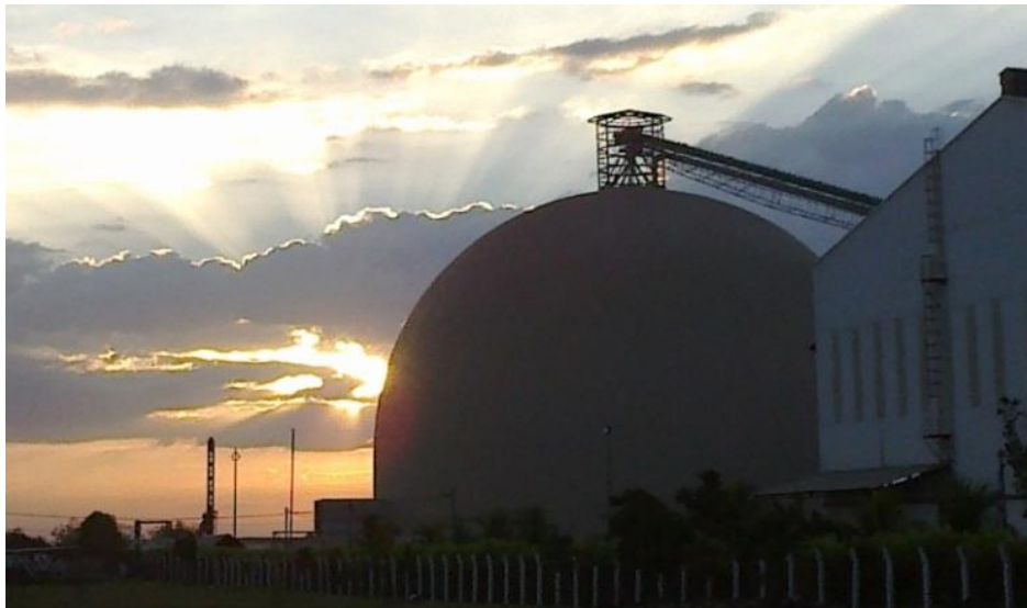
Figura 76. Vista de domo con estructura metálica de caseta principal en su ápice
