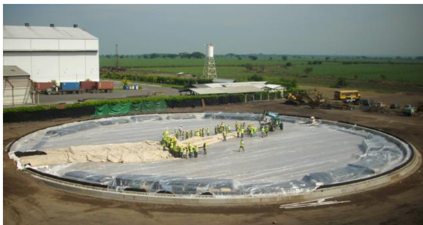
Figura 56. Despliegue longitudinal de formaleta inflable
