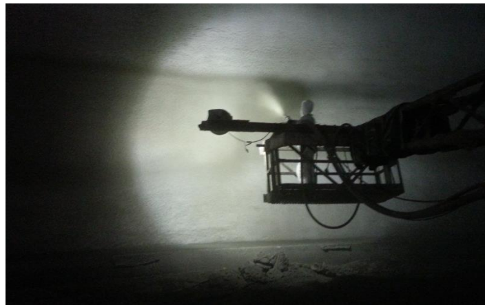
Figura 81. Limpieza de superficie con agua, previo a aplicación de pintura
