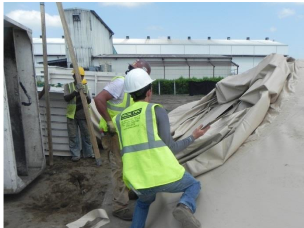
Figura 61. Colocación de esclusa para acceso de personal, previo a inflado
