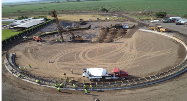
Figura 54. Fundición de viga anular, relleno estructural & construcción de columnas GeoPier
