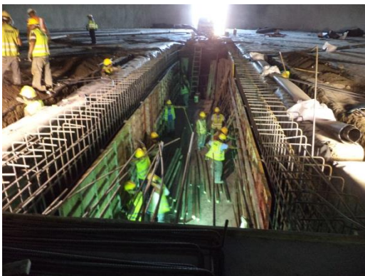
Figura 79. Construcción de túnel de descarga de producto almacenado
