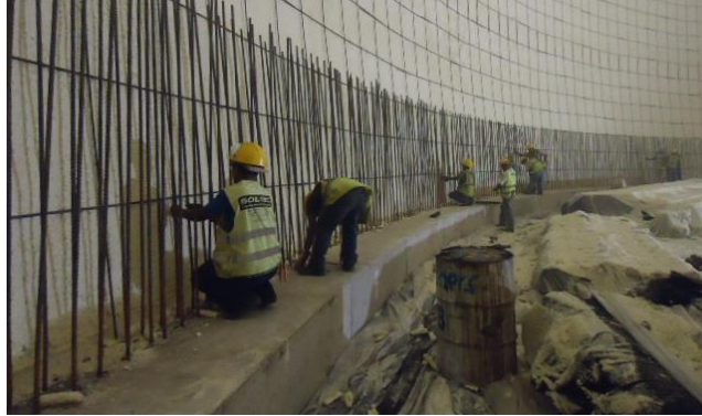
Figura 70. Colocación de acero estructural
