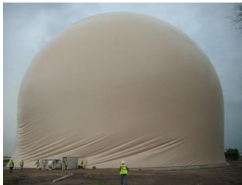
Figura 64. Formaleta inflable a un 85 % de su forma final
