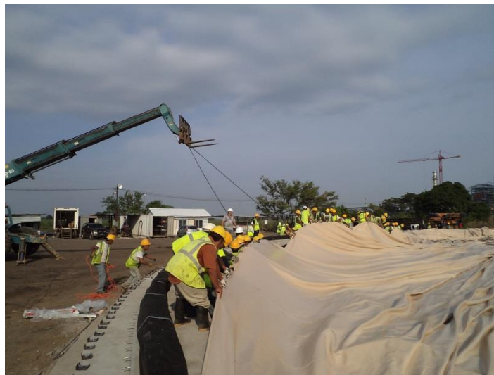
Figura 52. Sujeción de formaleta inflable a viga anular
