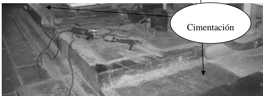
Figura 61. Cimentación de cernedora
