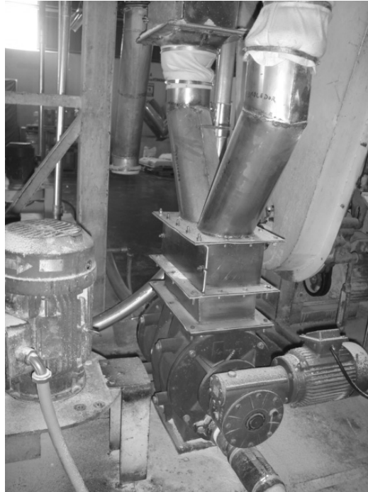
Figura 73. Nueva cernedora instalada y montada
