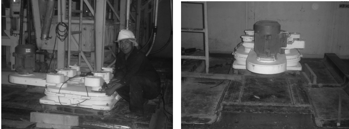
Figura 64. Transmisión instalada y colocada
