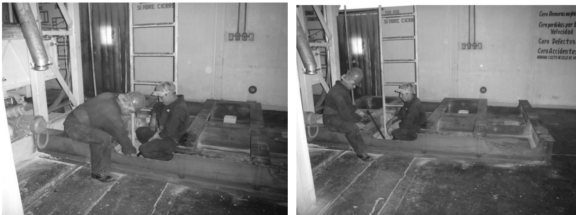
Figura 56. Personal instalando la estructura metálica
