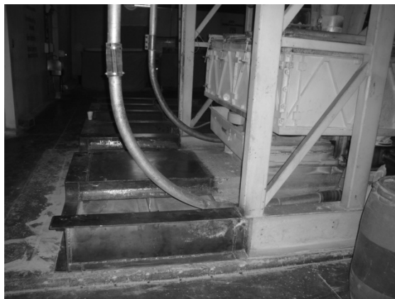
Figura 55. Estructura añadida a la actual
