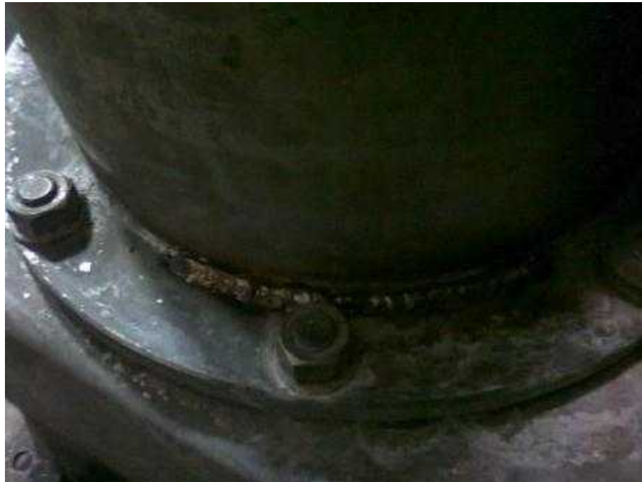
Figura 34. Soldadura de intercambiador de calor
