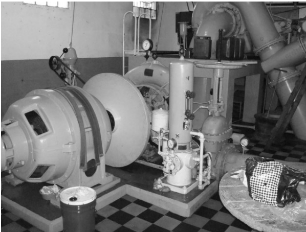
Generador y turbina Francis de 150 Hp.
