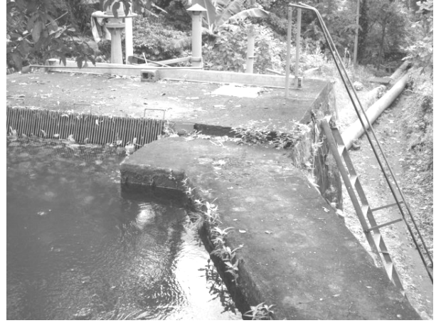
Canal de demasías y rejilla de filtración
