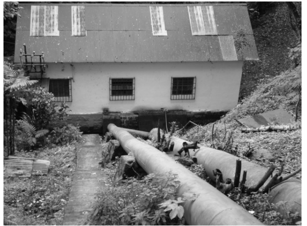
Tubería de presión y casa de máquinas
