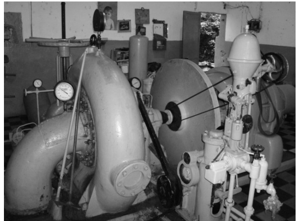
Generador y turbina Francis de 150 Hp.
