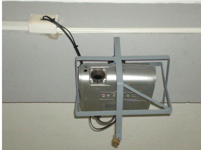
Vista frontal de jaula e instalación eléctrica de proyector en el laboratorio No. 2 del ITCoE
