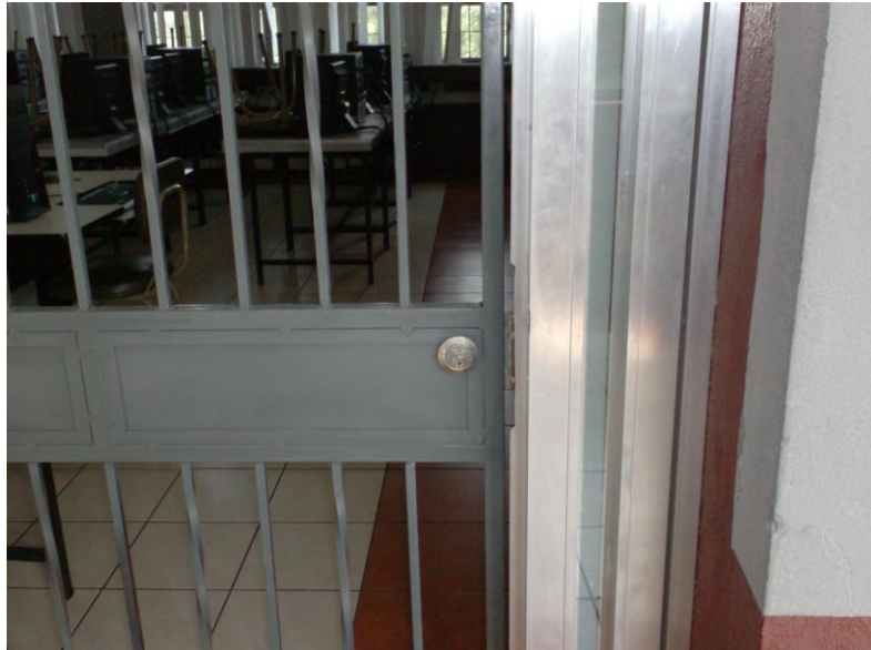
Chapas de rejilla interna de los laboratorios del ITCoE
