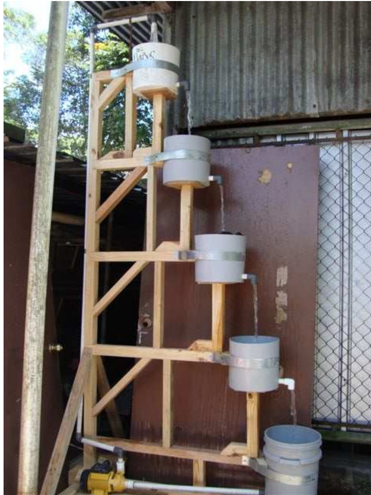
Figura 8 . Sistema de aireación tipo cascada
