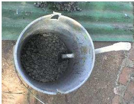
Instalación de grava como base y medio filtrante
