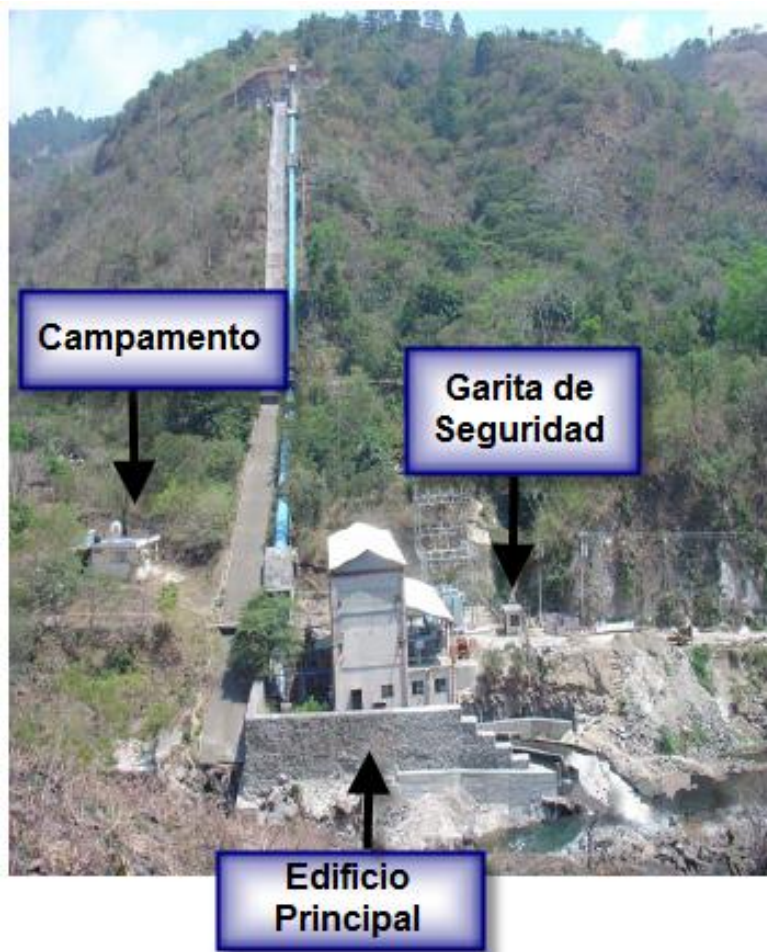
Figura 20. Vista general de Central Hidroeléctrica Poza Verde
