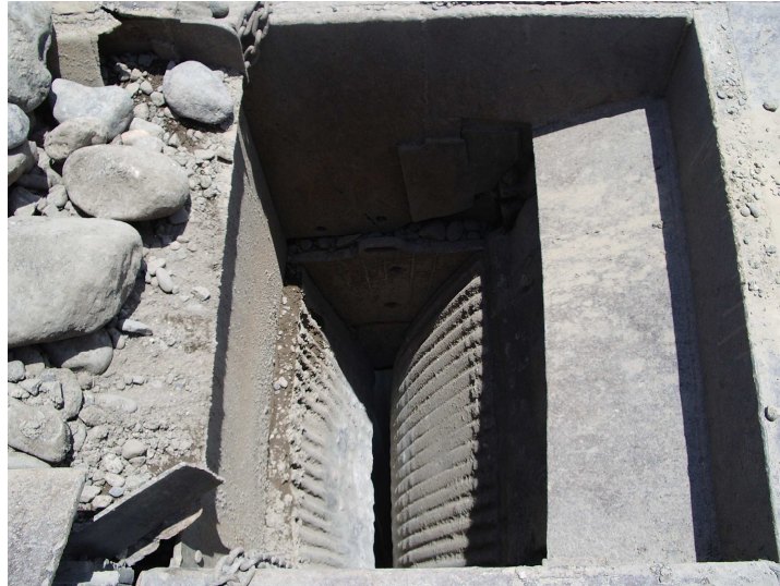
Figura 17. Parte superior de trituradora primaria
