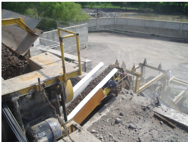
Figura 44. Material hacia zaranda secundaria
