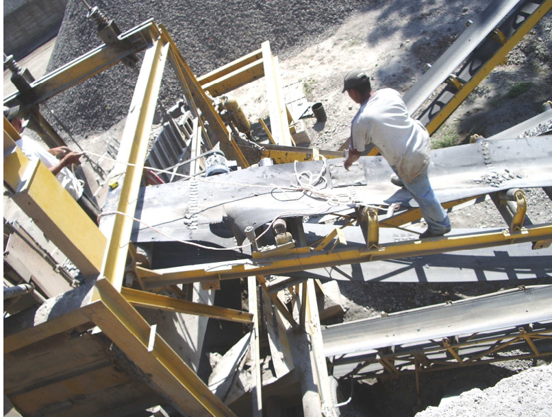
Figura 36. Reparación de banda transportadora
