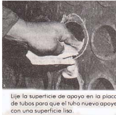
Figura 41. Lijado de superficie de la lamina o placa de tubos
