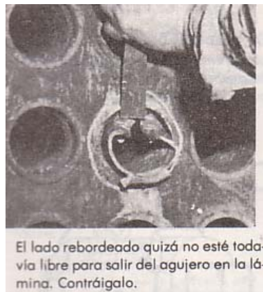
Figura 38. Contracción de tubo de humo
