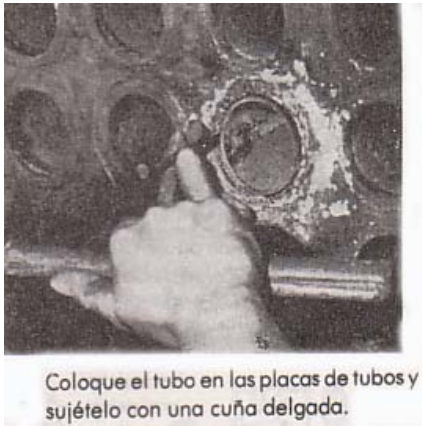
Figura 45. Tubo sujetado con cuña
