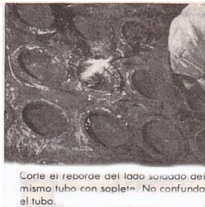
Figura 35. Corte del tubo con soplete
