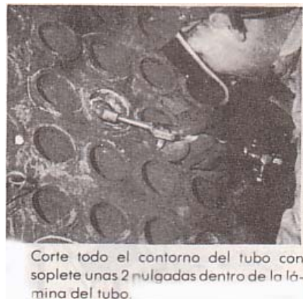
Figura 36. Corte del contorno del tubo con soplete
