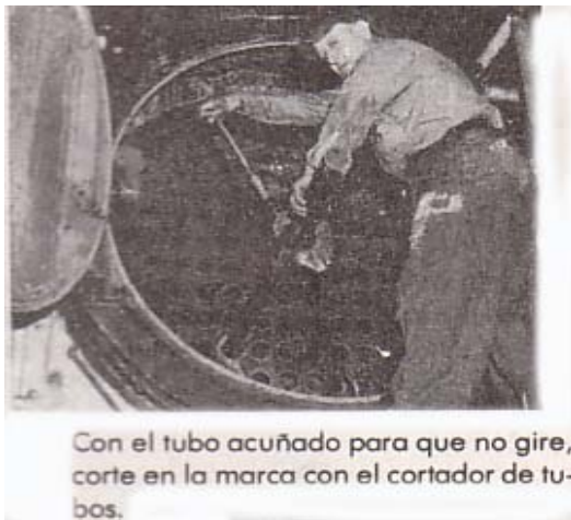
Figura 43. Corte de tubo
