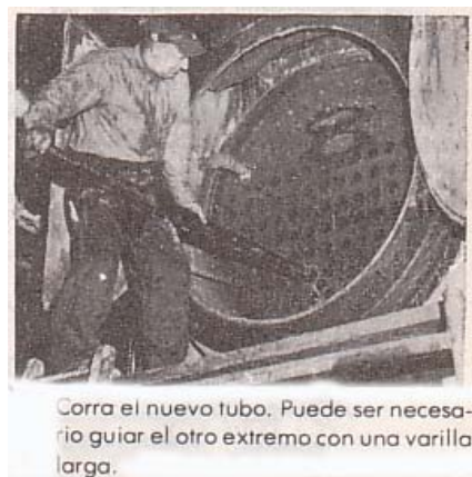
Figura 42. Introducción de tubo de humo nuevo
