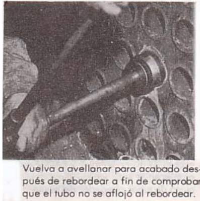
Figura 61. Avellanado para acabado
