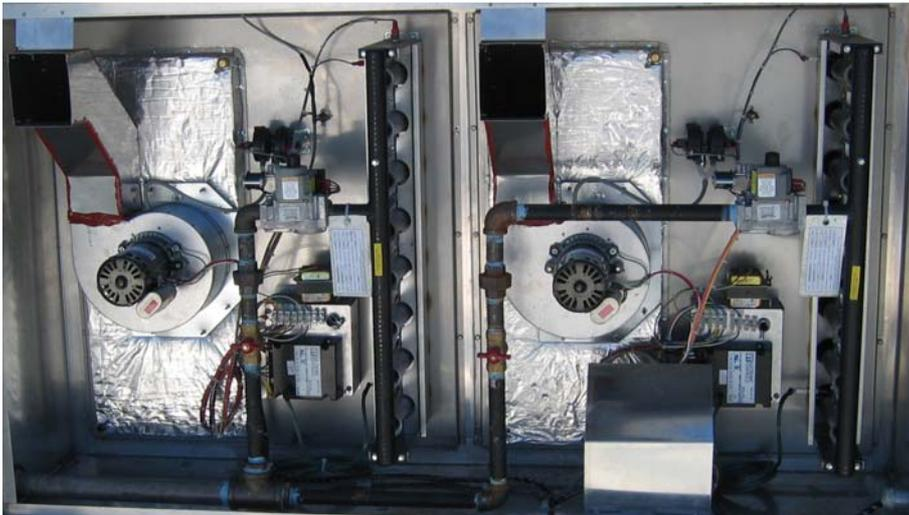
Esta figura muestra los quemadores, estos se encuentran en serie y el flujo del aire es de derecha a izquierda con referencia a la figura 25.
