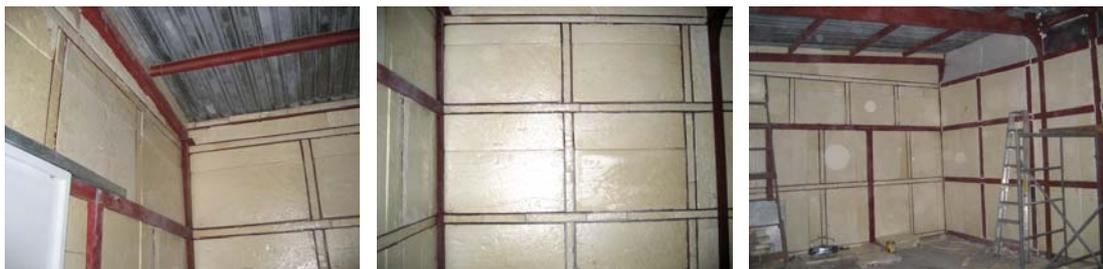
Al terminar con las planchas de poliuretano, se procedió a colocar planchas de plywood de ½ pulg. de ancho en todas las paredes y el techo de la cámara, para proteger el poliuretano. En la siguiente grafica de muestran las planchas de plywood sobre las de poliuretano.
