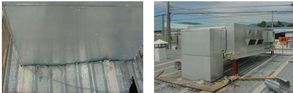
La primera sección del ducto se atornilla al equipo.
