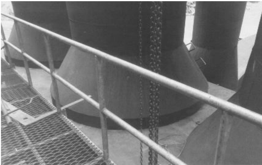
2) Techo modificado del colector de hollín de caldera 7 Ingenio Santa Ana
