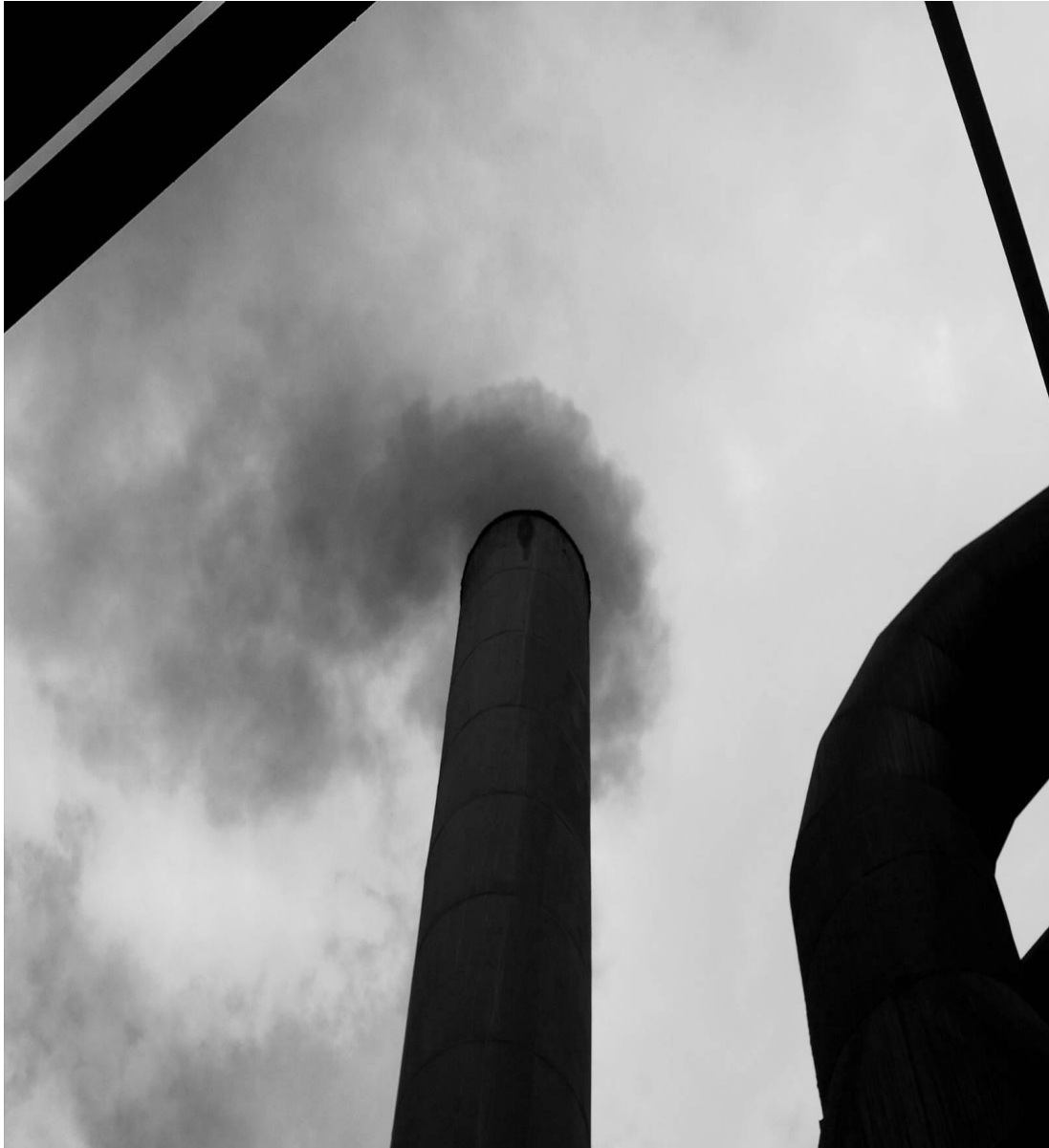
6) Mediciones de Ringelman chimenea caldera 7 Ingenio Santa Ana
