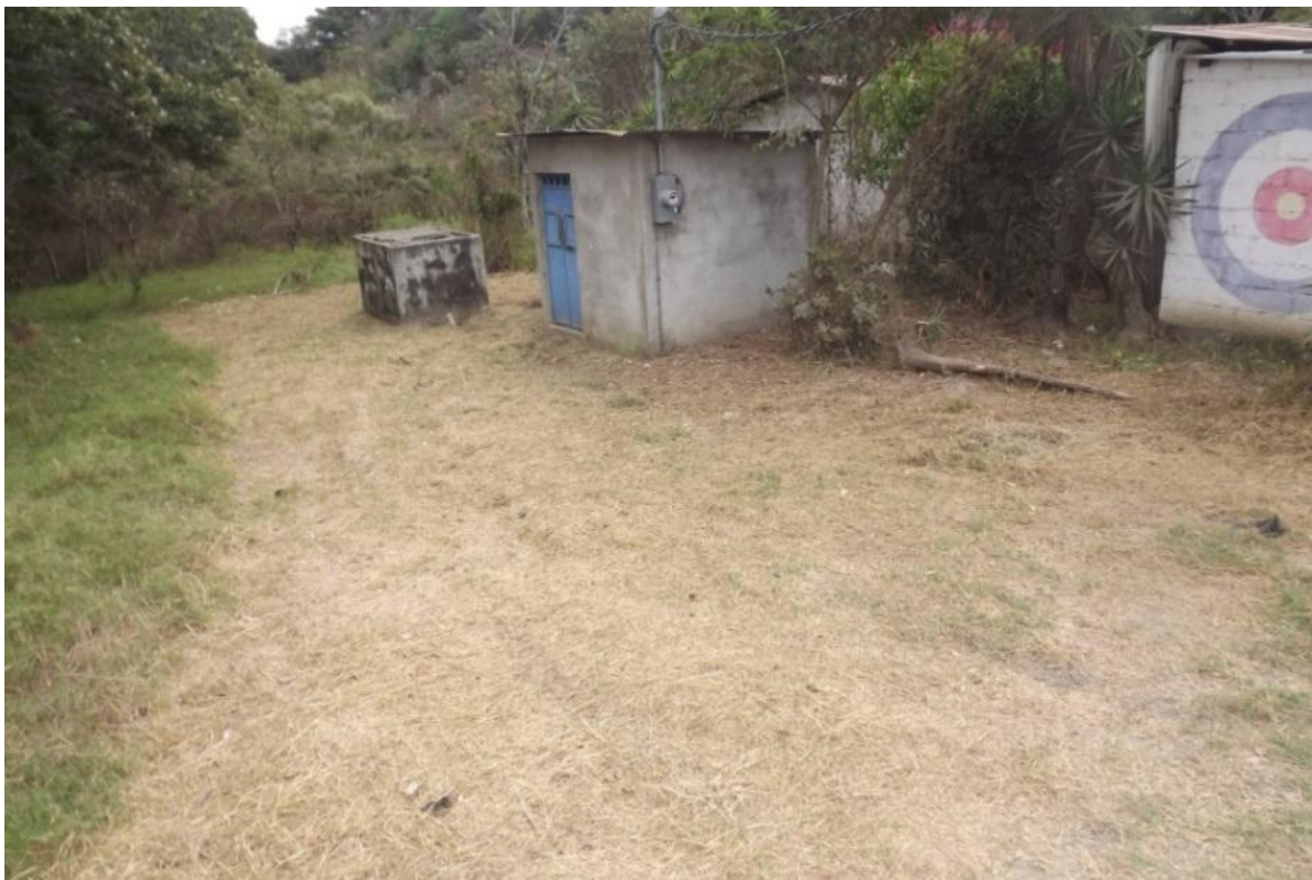
Figura 13. Pozo mecánico, sistema de agua El Naranjo
