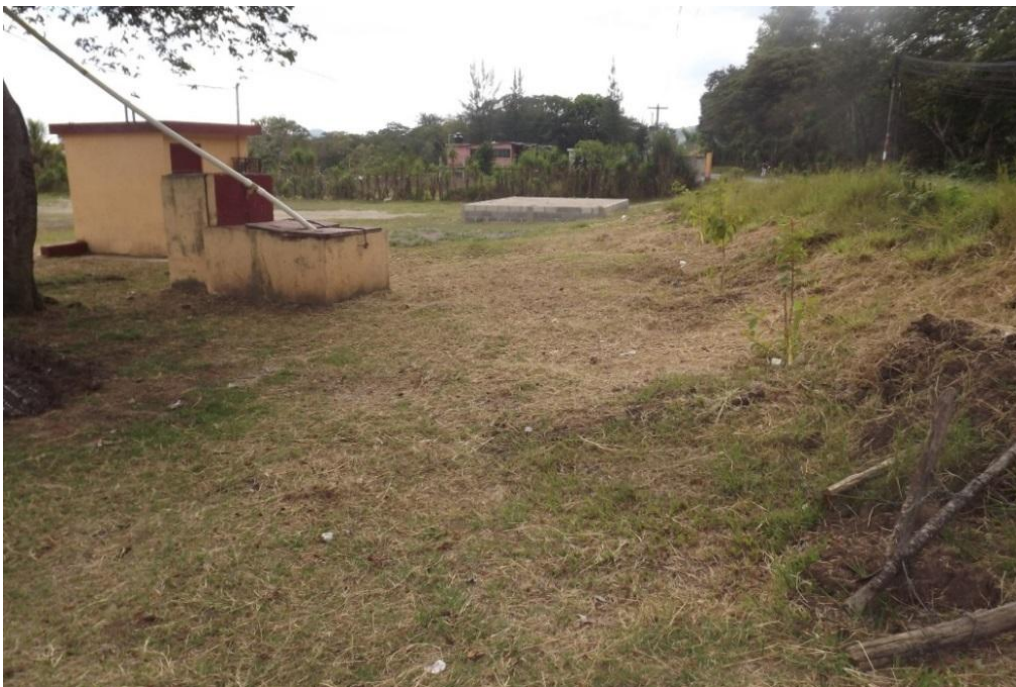
Figura 9. Pozo mecánico, sistema de agua Agua Blanca
