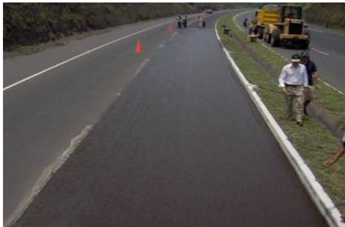
Figura 2. Aplicación de Lechada Asfáltica. Autopista Palin-Escuintla km. 25
