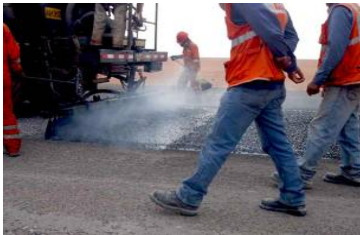
Figura 3. Aplicación de riego para tratamiento superficial
