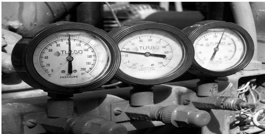
Figura 11. Evacuación del sistema de refrigeración con medidor de micrones
