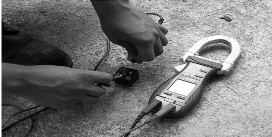
Figura 6. Prueba de continuidad en relé
