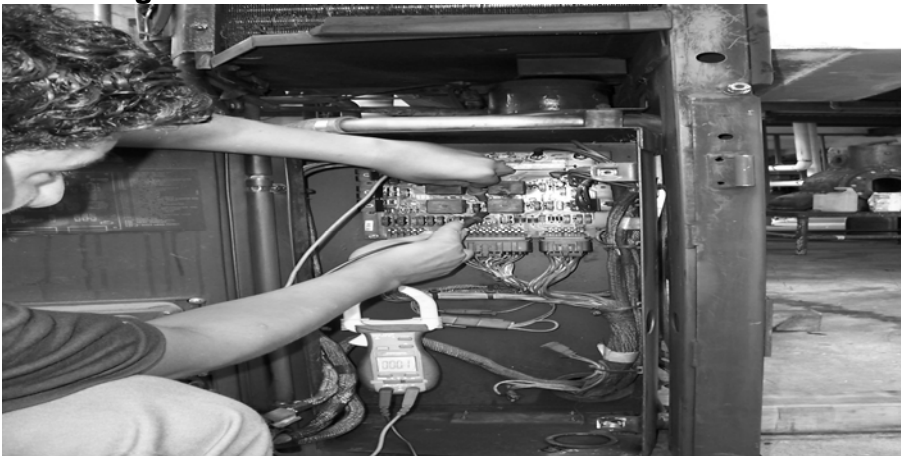
Figura 5. Procedimiento de revisión de diodos
