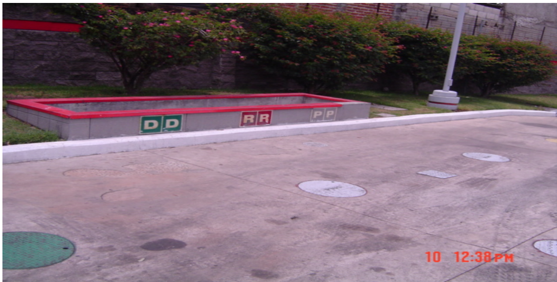
Figura 2. Área de descarga de combustible
