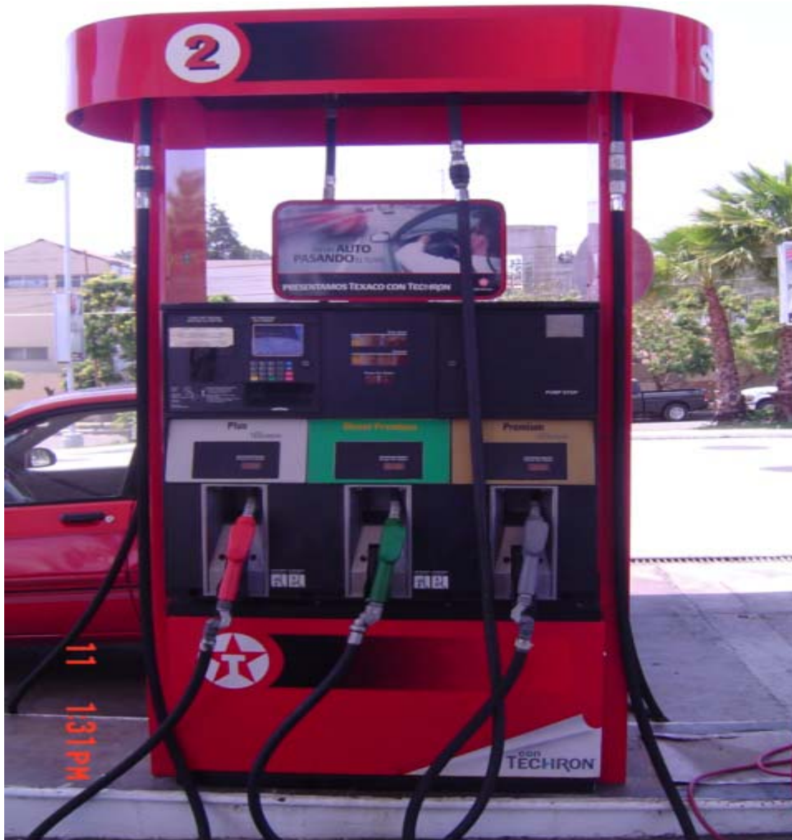
Figura 3. Dispensador multiproducto para combustible
