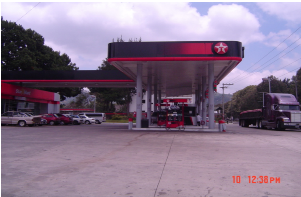
Figura 1. Estación de servicio Texaco área de despacho de combustible.
