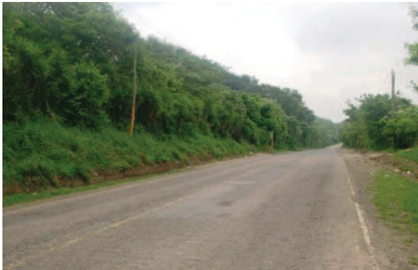
Figura 21. Fotografía del tramo carretero, estación 90+350
