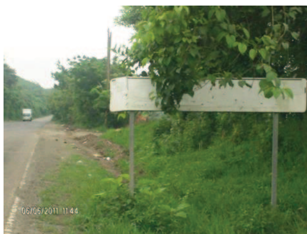
Figura 22. Fotografía señalización vertical dañada, estación 90+360
