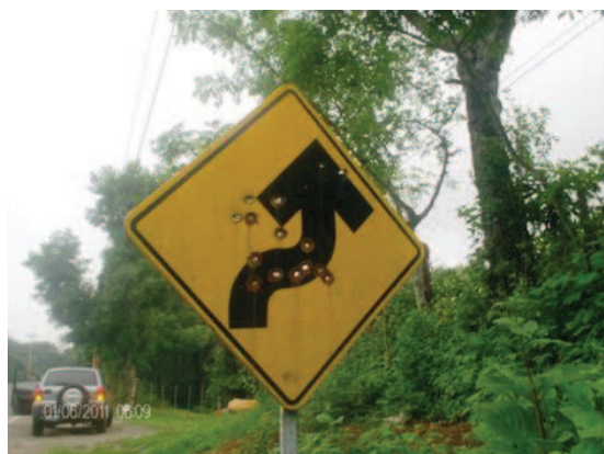
Figura 23. Fotografía señalización vertical dañada, estación 91+320
