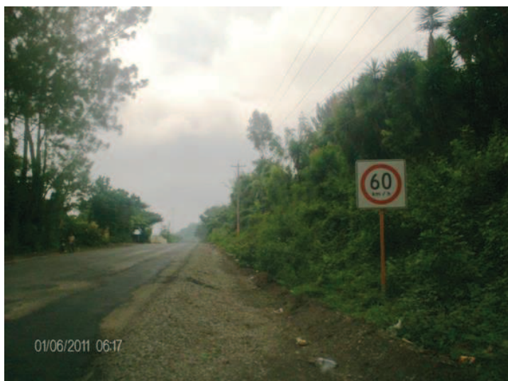
Figura 25. Fotografía señalización horizontal dañada, estación 89+637
