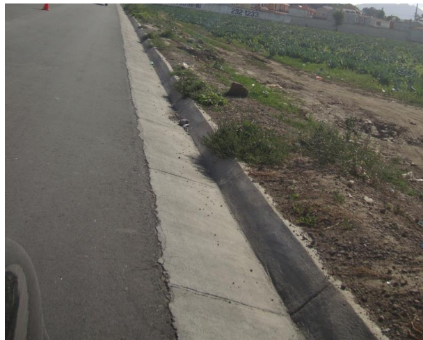
Figura 9. Cuneta tipo L
