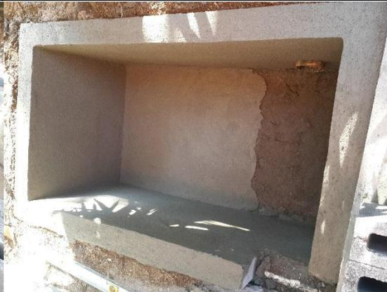
Repellado para impermeabilización.
