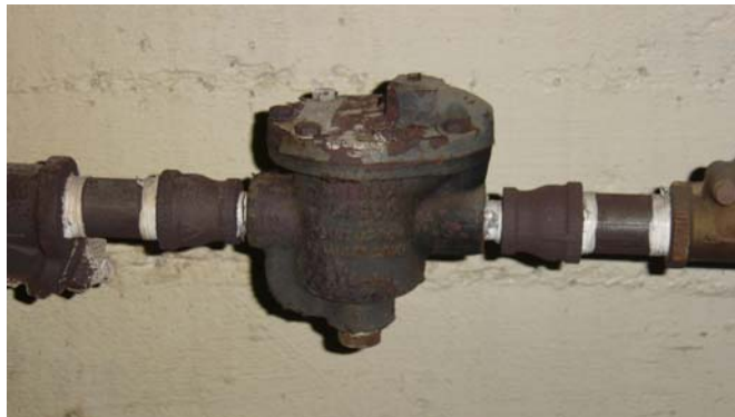
Figura 5. Fotografía trampa de vapor de cubeta invertida
