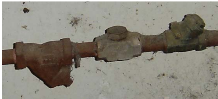
Figura 6. Fotografía trampa de vapor termodinámica
