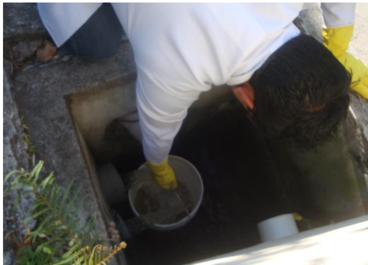
Figura 13. Realización del aforo
