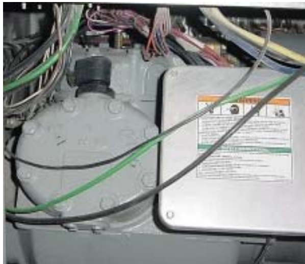
Figura 12. Bobina del solenoide que acciona el descargador de cilindros.
