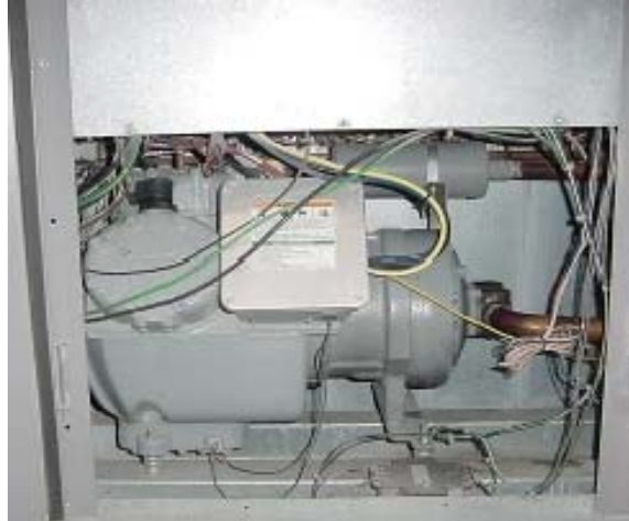
Figura 12. Bobina del solenoide que acciona el descargador de cilindros.
