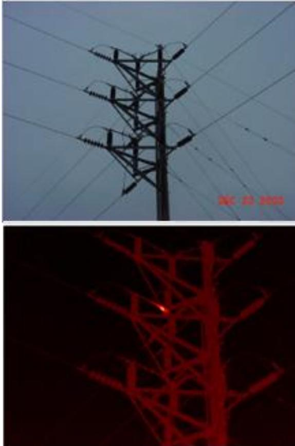
Fuente: Inspección termográfica. [www.fluke.com](http://www.fluke.com). Consulta: julio 2017.
