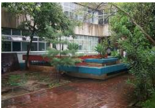
A. Boveda de trafo de distribución núm. 33 (3x25 kV) del edificio M-1.
