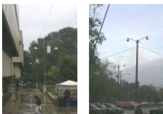
D. Circuitos de alumbrado público frente a los edificios S-3 & S-6, y parqueo del edificio M-4.
