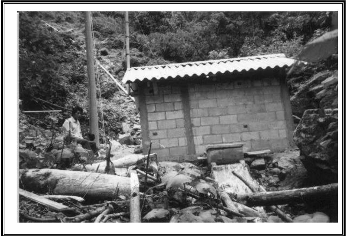
Vista posterior de la casa de máquinas. Nótese la tubería forzada y el canal de descarga.
