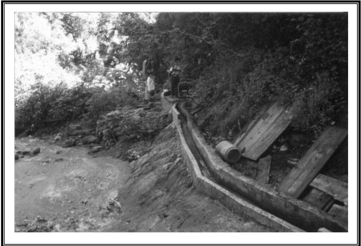
Vista del canal. Nótese el cambio de altura de una pared para que actúe de vertedero lateral. Al fondo el depósito de sedimentación, resalta el canal de piedra que se construyó a la izquierda de dicho depósito, para cuando se abra la puerta corrediza y el sedimento fluya.
