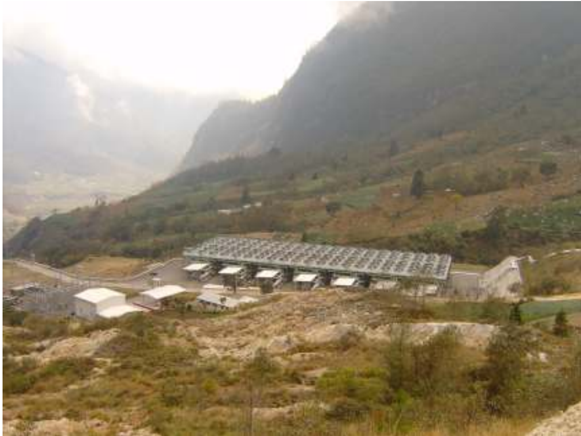
Figura 11. Planta geotérmica Orzunil 1.
