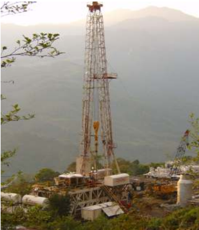
Figura 10. Perforación pozo ZD-6.
