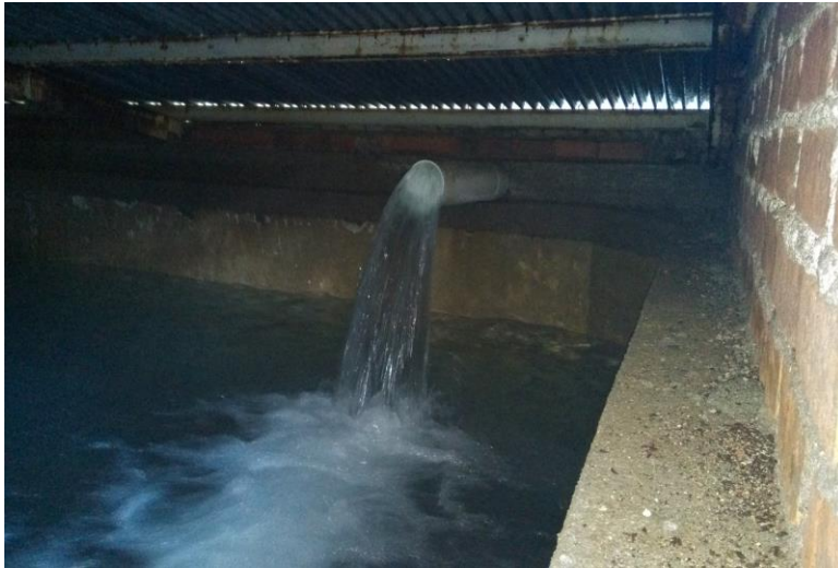
Figura 13. Interior tanque EI INDE
