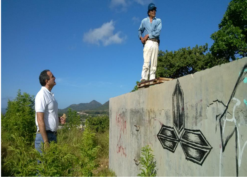
Figura 15. Exterior del tanque La Lomita
