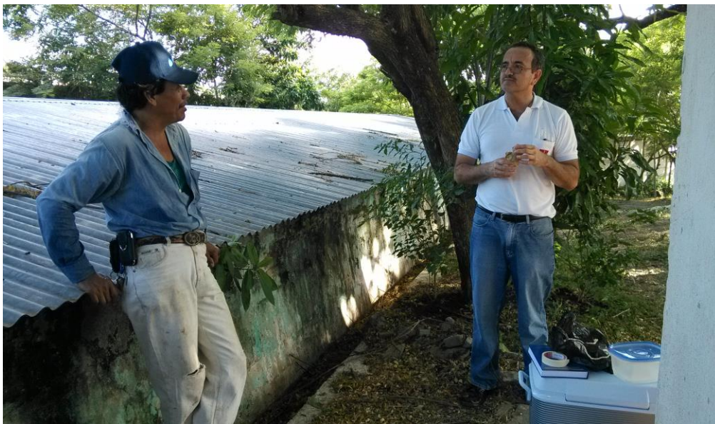
Figura 14. Exterior del tanque EI INDE
