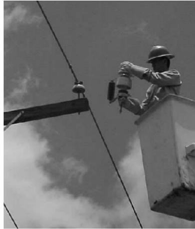
Figura 71. Instalación de los pararrayos con cuerno de arqueo (2)
