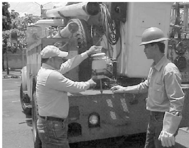
Figura 70. Instalación de los pararrayos con cuerno de arqueo (1)
