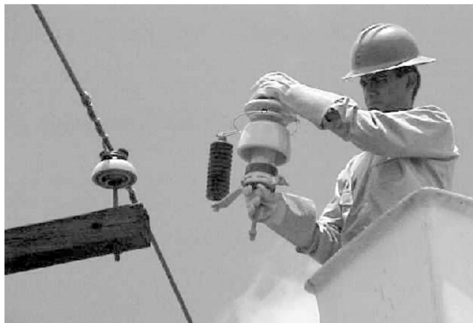
Figura 72. Pararrayos con cuerno de arqueo formalmente instalados
