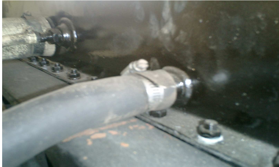
Figura 17. Mangueras del sistema de enfriamiento
