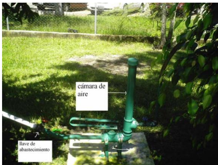
Figura 4. Ariete hidráulico y sus componentes
