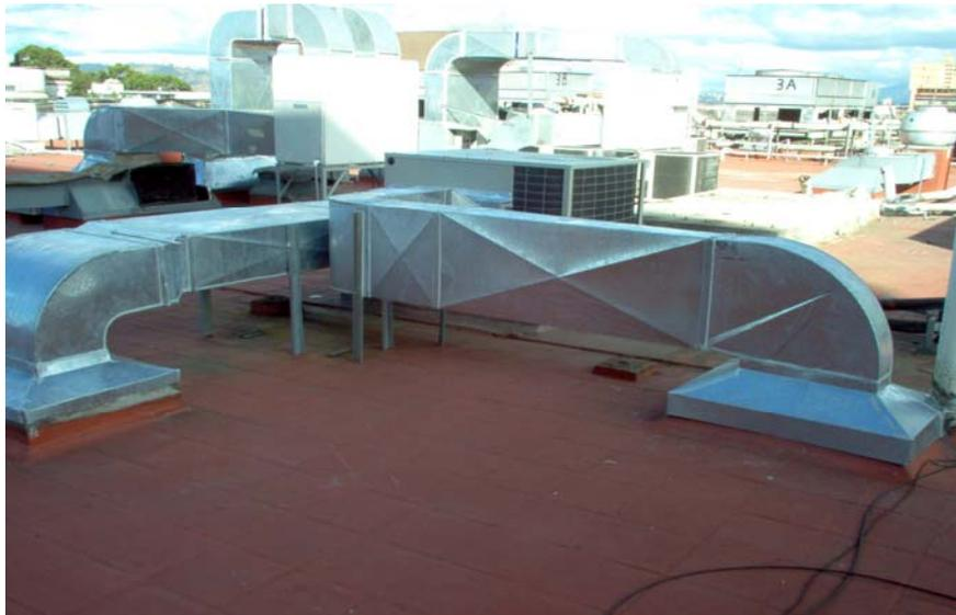
Los dos equipos aportan conjuntamente al local una capacidad de refrigeración de 15 toneladas equivalente a 180,000 Btu/hr, que son las necesarias para contrarrestar la carga generada en el área de central de equipos del hospital San Juan de Dios.
