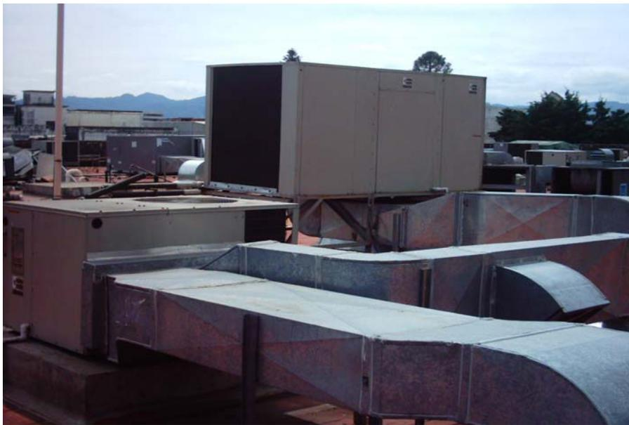
El equipo que se presenta en la figura 27 es un tipo paquete con una capacidad de enfriamiento de 60,000 Btu/hr, equivalente a 5 toneladas de refrigeración, las características de los equipos de éste tipo dependen de su capacidad en enfriamiento.
