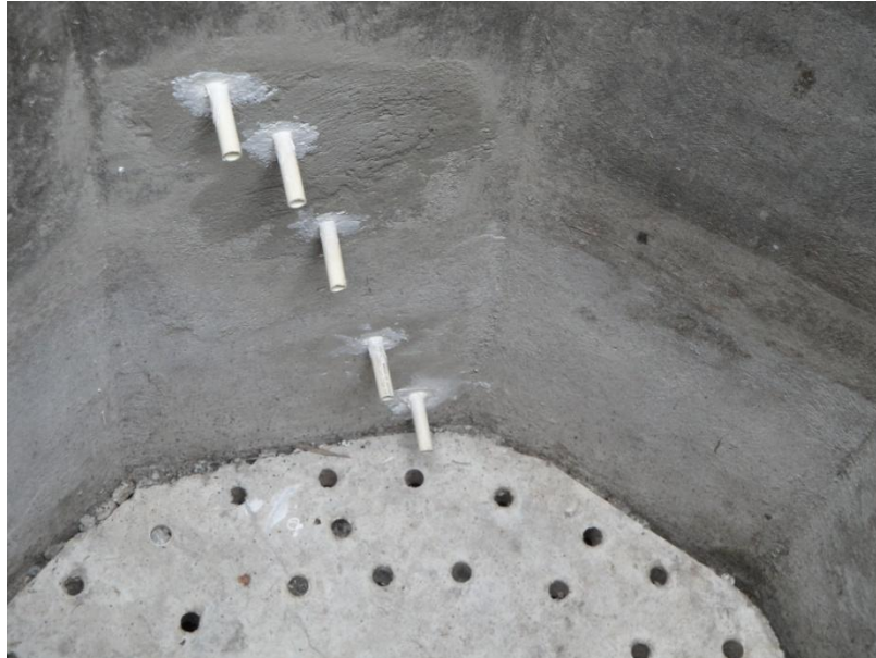
Figura 13. Vista de la disposición real de los piezómetros en el interior del filtro para medición de la pérdida de carga
